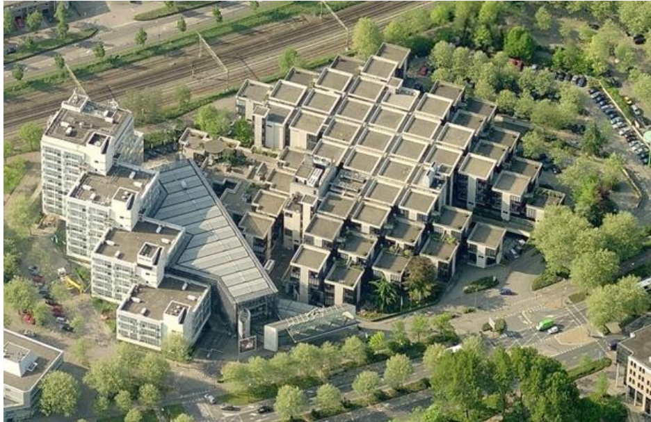
Het beroemde Herzberger gebouw (voormalig Centraal Beheer) met de Pakhoektorens
